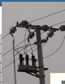
Odklopniki z zaščito v SN omrežju (izven RTP)
